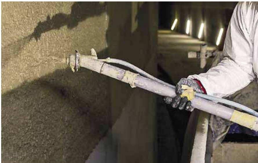
Bis zu 40 mm „ip 160“-Brandschutzputz wurden bei der Sanierung des Tunnels im Spritzputzverfahren aufgetragen.
