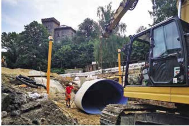
Baggertechnik ist ausreichend, um die GFK-Maulprofile 3.200 × 2.000 auf der Baustelle zu bewegen.
