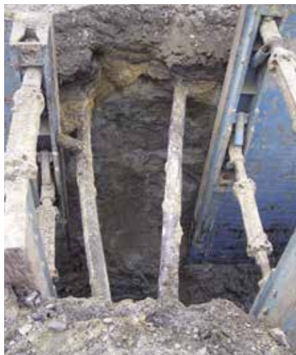
Fehlender Verbau im Bereich kreuzender Leitungen
