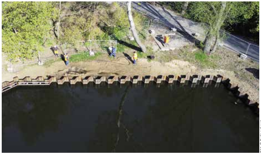
Sicherung des abgesperrten Bereichs
