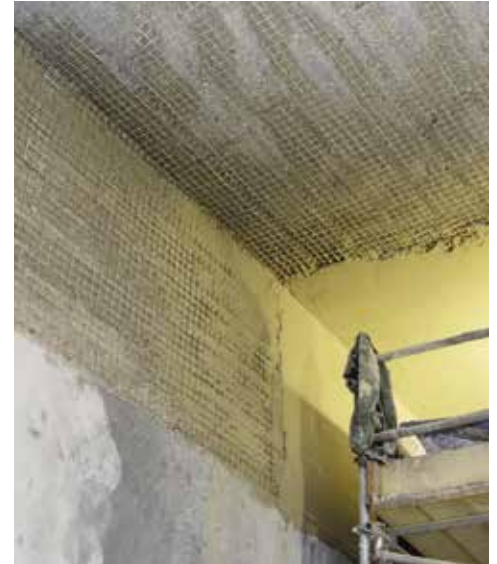
Ergänzend zur Haftbrücke wurde vor dem Aufspritzen des Brandschutzputzes eine Edelstahlbewehrung (50 × 50 mm) als Putzträger integriert.
