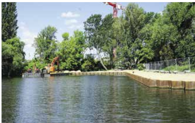
Sicherung der Böschung im Uferbereich
