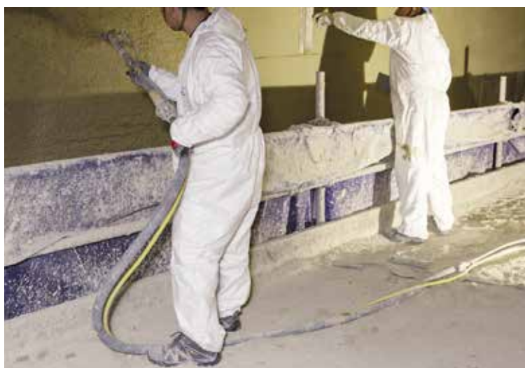
Teamarbeit beim Aufspritzen und Glätten
