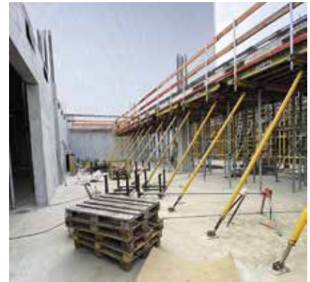
MK-Deckentische, die auch für die Schalung der massiven Unterzüge eingesetzt wurden
