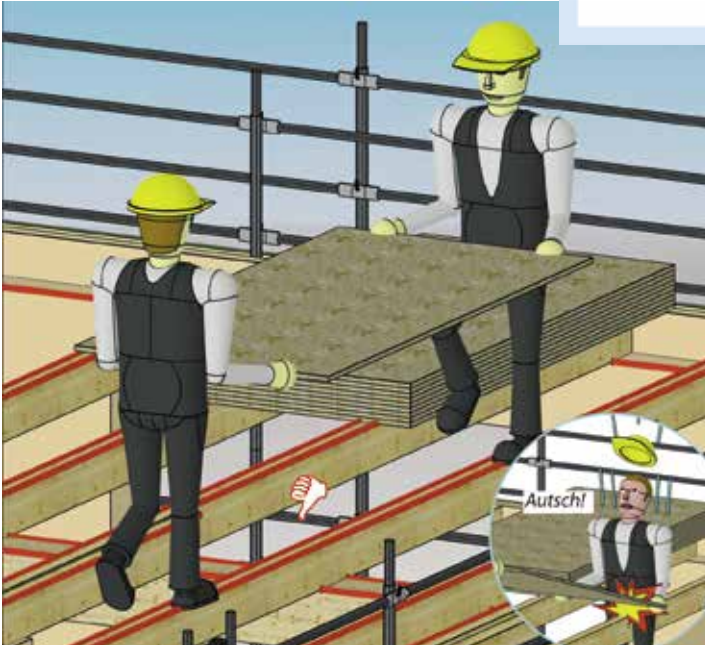
Abb. 1: Offene Balkenlage: Jede obere Kante ist eine Absturzkannte.
