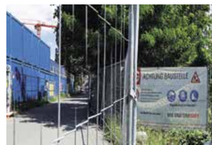
Ein Bauzaun sichert den Uferweg ab.
