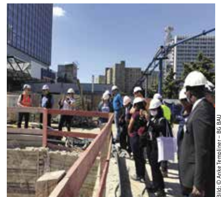
Die anwesenden Bauleiter von Covivio und Implenia erläutern den Stand der Bauarbeiten.
