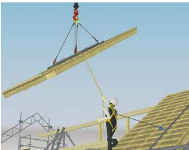
Abb. 4: Höhensicherungsgerät als Rückhaltesystem an Schiene angeschlagen
