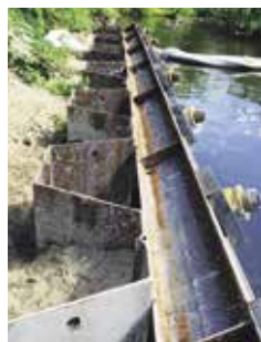
Sicherung der Böschung im Uferbereich
