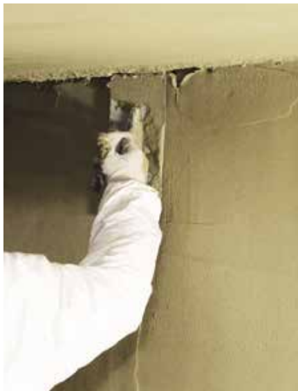
Der Brandschutzputz „ip 160“ lässt sich leicht mit üblichem Equipment verarbeiten und in hoher Oberflächenqualität glätten bzw. filzen.
