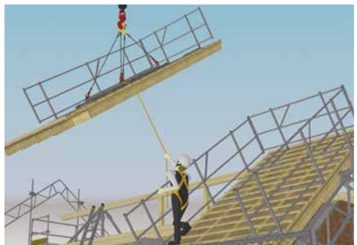
Abb. 5: Besser geht es nicht: Seitenschutzsystem wird bereits auf dem Lkw aufgeschraubt.
